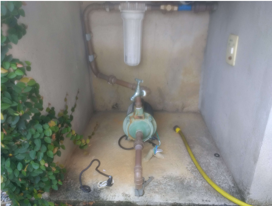
Figura 3.36 – Motobomba instalada na cisterna.
